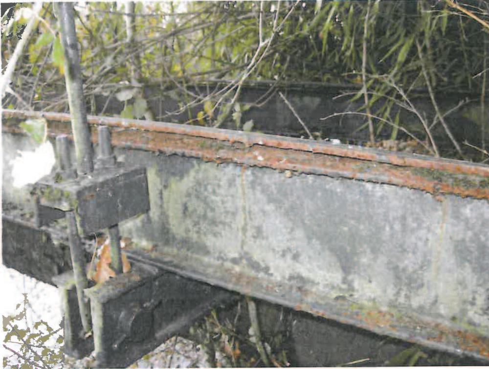
Système de fixation des câbles de suspente
