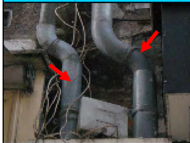
Descentes pluviales en doublon
